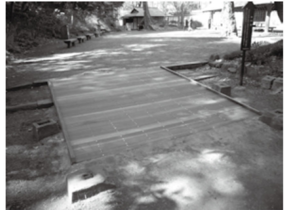
写真4 取り外しができる段差解消スロープ
