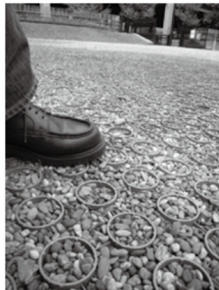
写真 2 砂利の中に樹脂製の資材を埋め込んだ例
